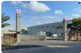
中壢自強廠 Chung-Li Plant 4
