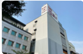
中壢三廠 Chung-Li Plant 3
