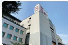
中壢三廠 Chung-Li Plant 3
