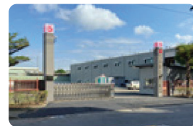
中壢自強廠 Chung-Li Plant 4
