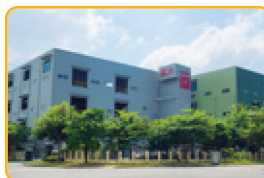
高雄本洲廠 Kaohsiung Ben-Chou Plant
