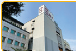
中壢三廠 Chung-Li Plant 3
