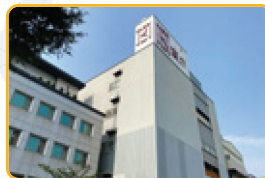
中壢三廠 Chung-Li Plant 3
