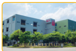
高雄本州廠 Kaohsiung Ben-Chou Plant
