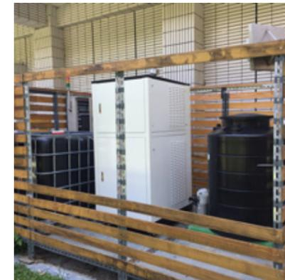
甲醇重組 / 質子交換膜 (PEM) 燃料電池發電系統 /
