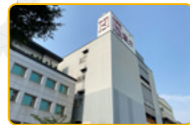
中壢三廠 Chung-Li Plant 3
